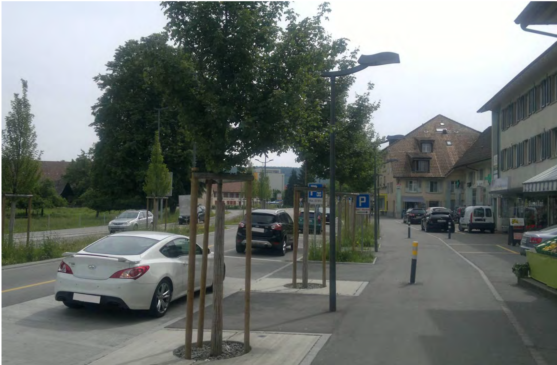
Windisch – nachher Bild: Abteilung Tiefbau Kanton Aargau
