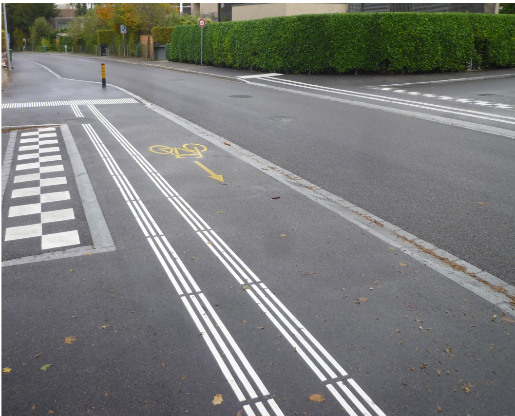
Image : PA2, Neubadrain à Binningen (Agglo Basel)
